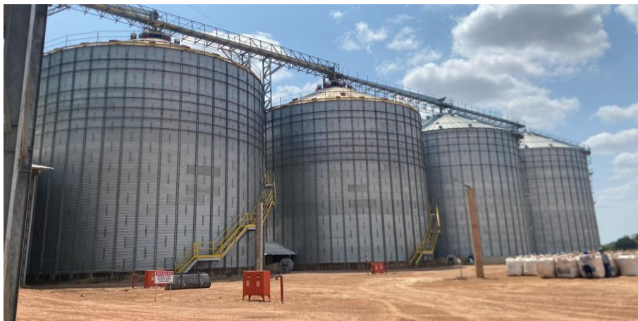
Figura 17. Complexo de recebimento, armazenagem, secagem e entrega de grãos (silos, moegas e secadores).
