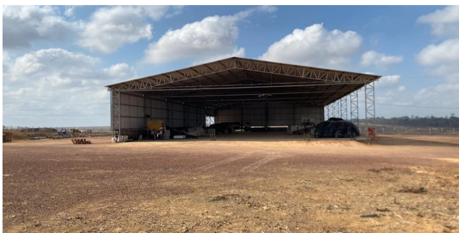
Figura 28. Galpão a nova fabrica de ração.
