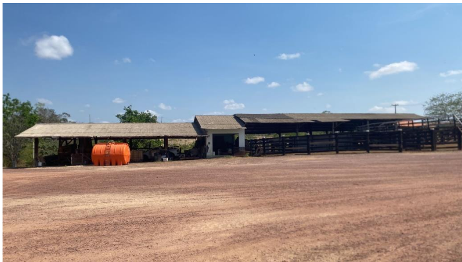
Figura 34. Galpão e Curral.
